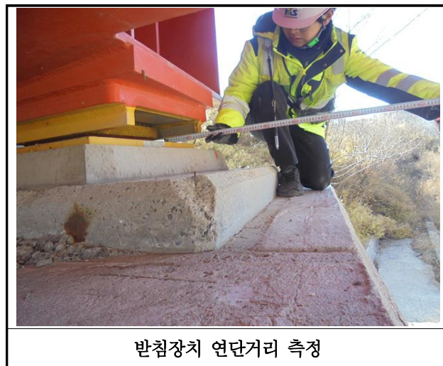
【사진 30.3.14】 교량받침장치 연단거리측정
