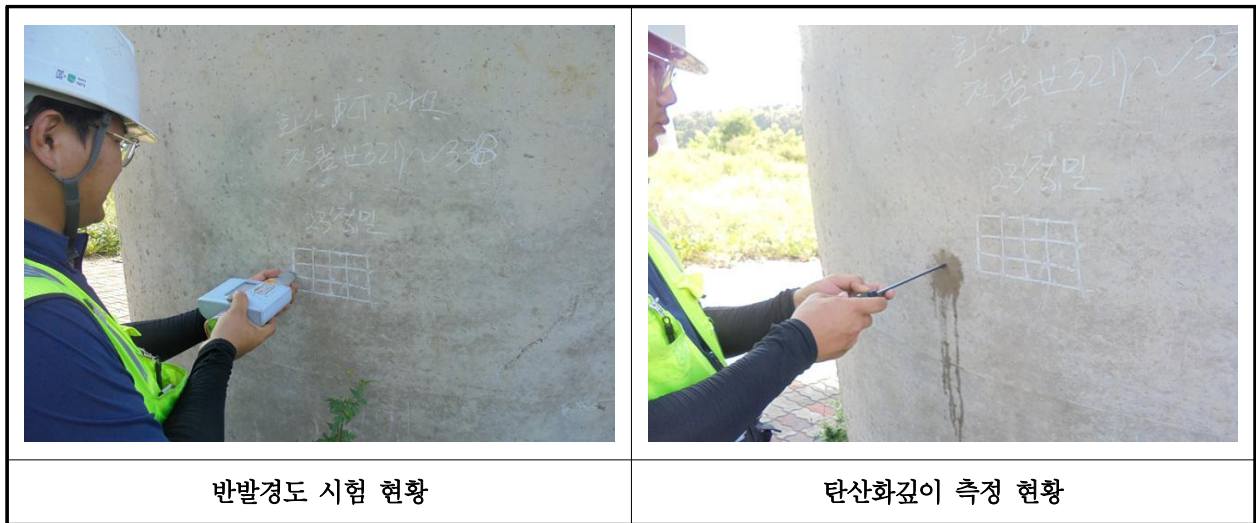
【사진 30.4.1】 콘크리트 내구성조사 현황
