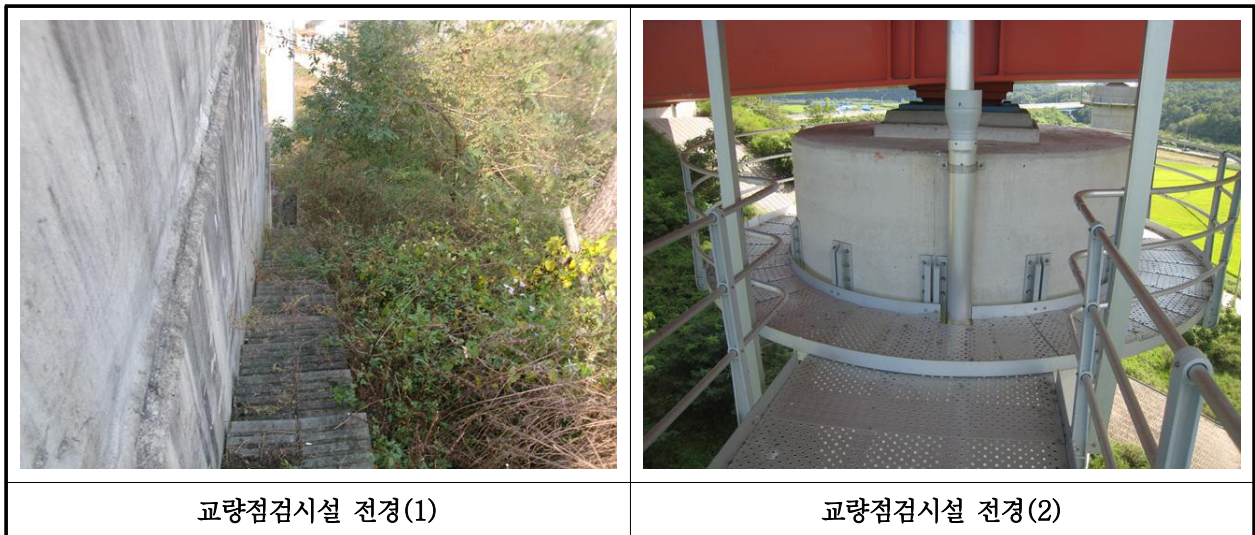
【사진 30.3.25】 교량 점검시설 전경
