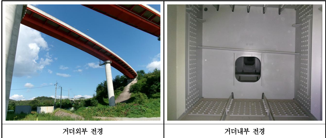
【사진 30.3.4】 거더 전경
