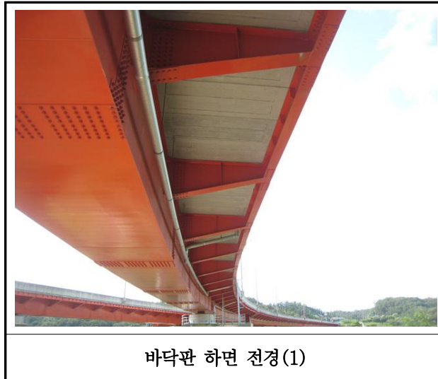
【사진 30.3.2】 바닥판하면 전경
