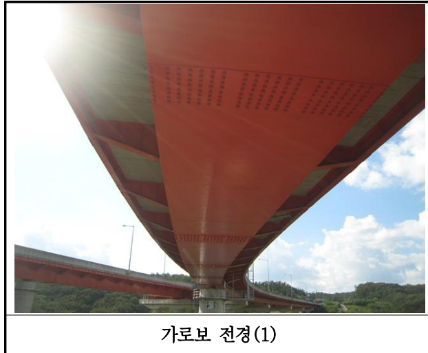
【사진 30.3.6】 가로보 전경
