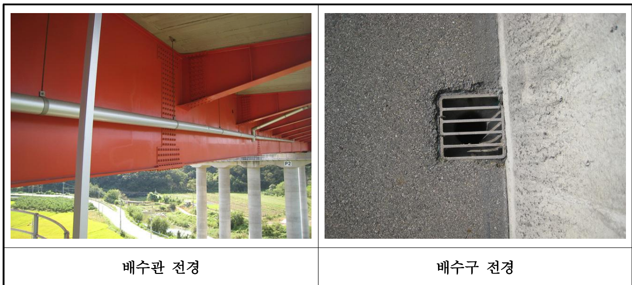
【사진 30.3.21】 배수시설 전경
