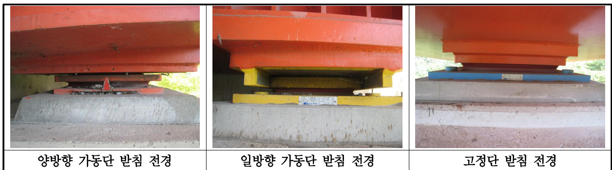
【사진 30.3.12】 교량받침 전경
