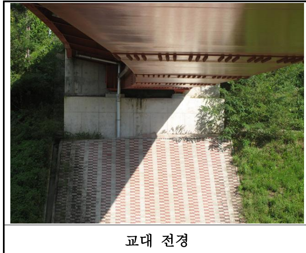
【사진 30.3.8】 교대 전경
