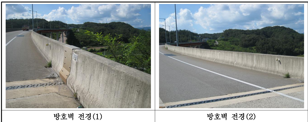
【사진 30.3.23】 방호벽 전경
